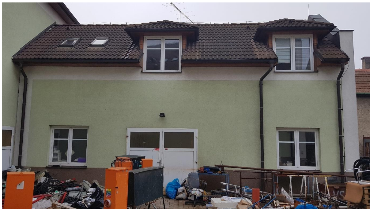
Obrázek 20 Pohled ze dvora na jižní část objektu
